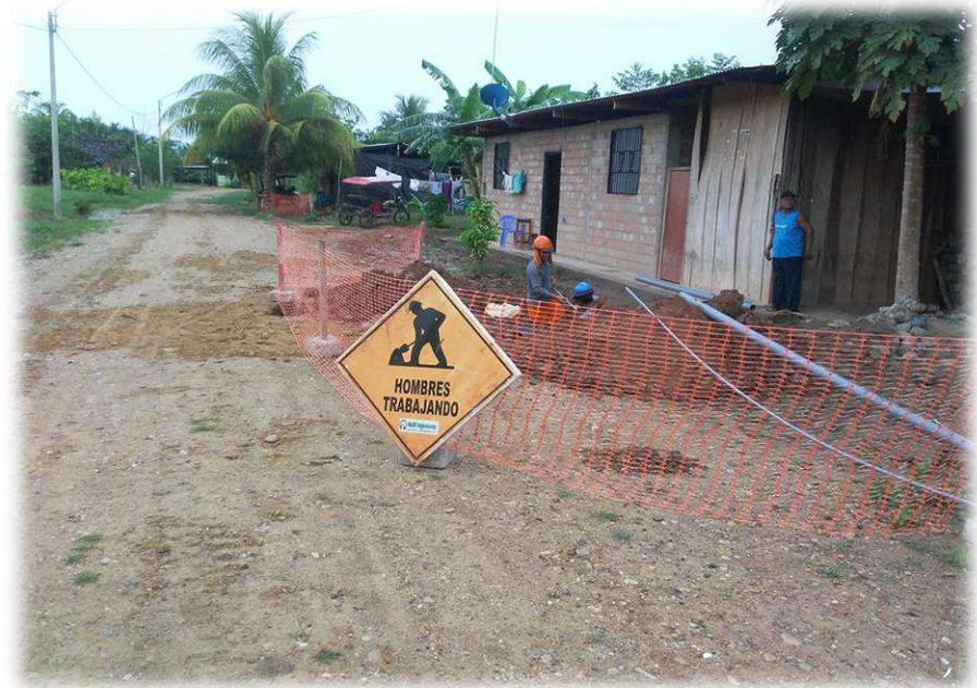
**EXCAVACION DE CONEXIÓN DOMICILIARIA DE AGUA POTABLE**
