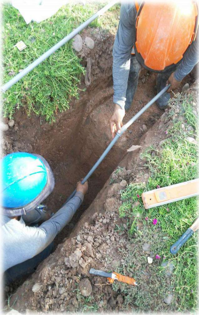
INSTALACION DE TUBERIA PARA CONEXIÓN DE AGUA POTABLE
