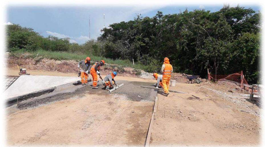
**Vaciado de solado en plataforma de la poza de sedimentación de lodos**
