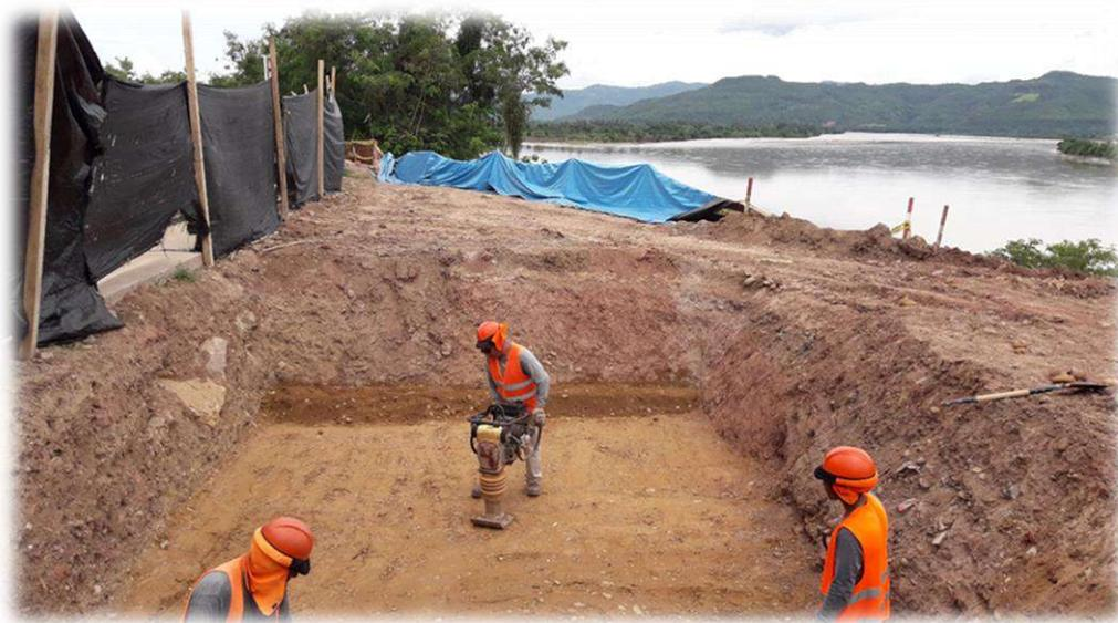
Relleno y compactación en cimentación en la caseta del grupo electrógeno
