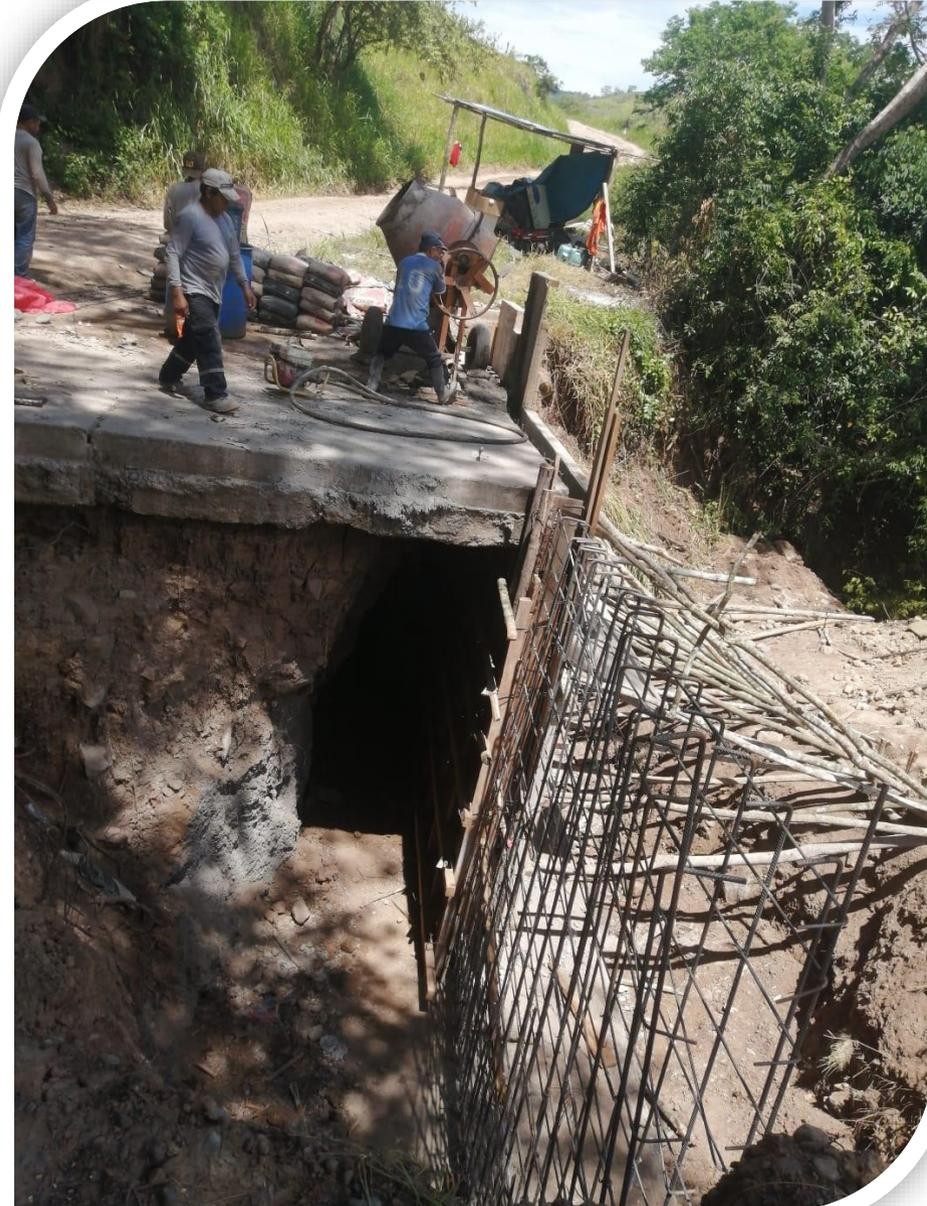
Encofrado del muro de concreto ciclópeo con una armadura de 3.00 m de altura y 10.00 m de largo.
