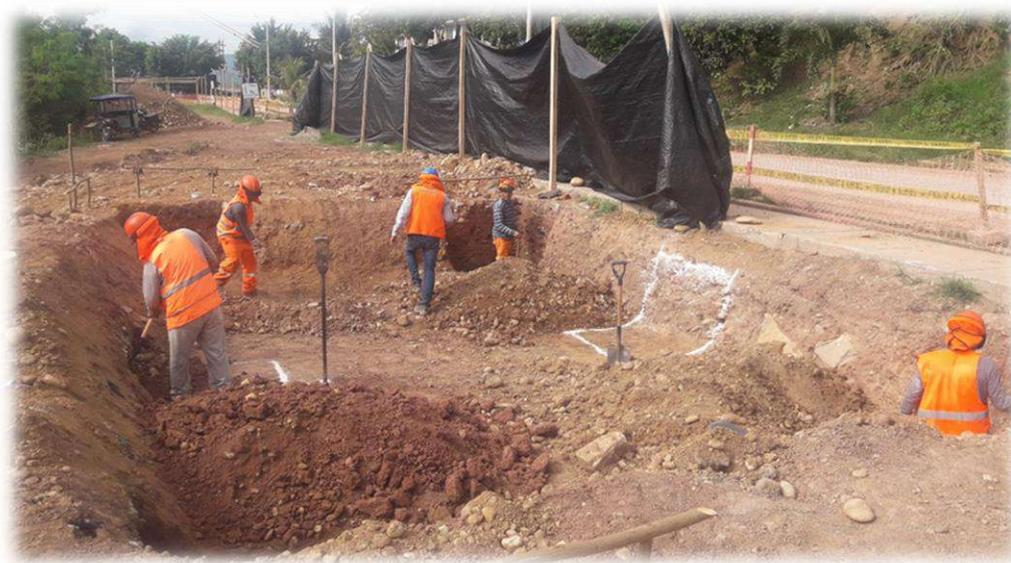
Trazo y nivelación de la caseta del grupo electrógeno
