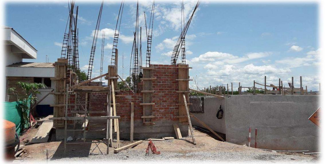
**Encofrado de columnas en sala de Dosificación del PTAP**
