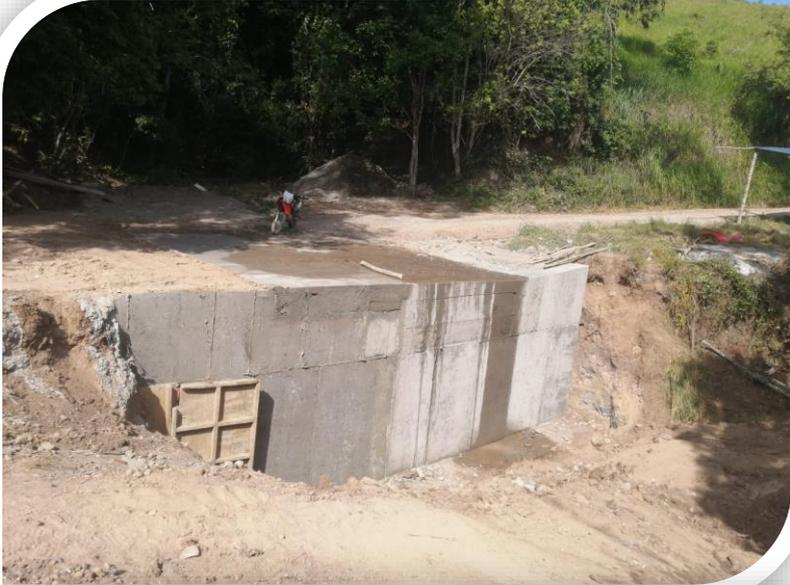
Muro de concreto ciclópeo después del vaciado debidamente conformado.
